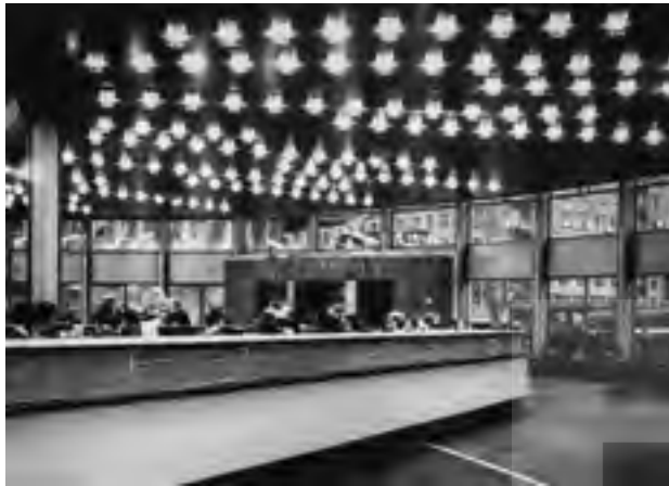
Wnętrze Rotundy PKO w dniu otwarcia, 1966. Archiwum rodzinne Interior of the PKO Rotunda on its day of opening, 1966. Family archive
