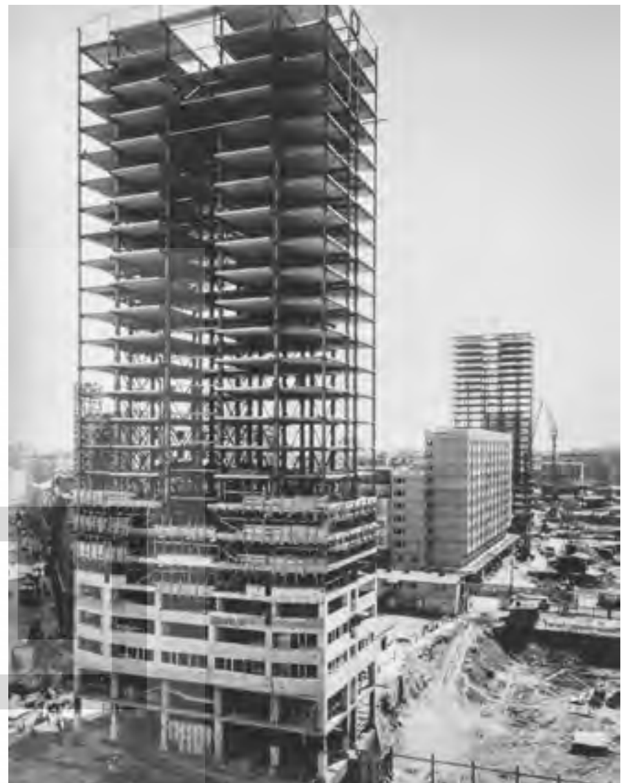
Budowa Ściany Wschodniej, na pierwszym planie wieżowiec przy ulicy Zgoda 13. Archiwum rodzinne Construction of the East Wall. In the foreground: tower block at number 13 in Zgoda street. Family archive
