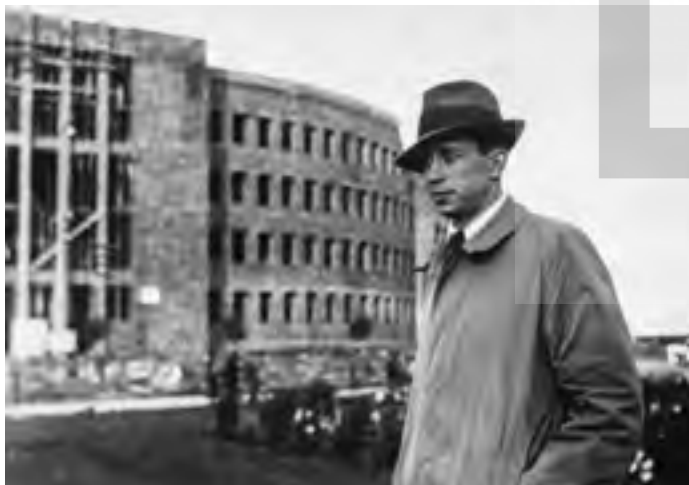
Zbigniew Karpiński na tle budowy gmachu sądu w Gdyni. Archiwum rodzinne Zbigniew Karpiński with the Gdynia Courthouse construction site in the background. Family archive
