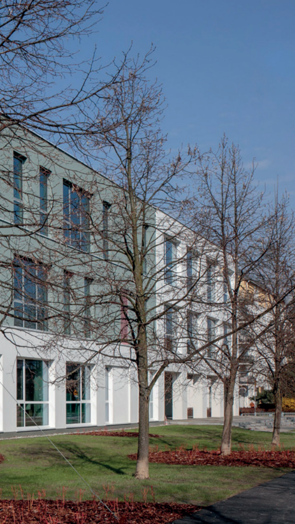
WIDOK NA BOCZNĄ ELEWACJĘ SZKOŁY I TEREN WYPOCZYNKOWY
