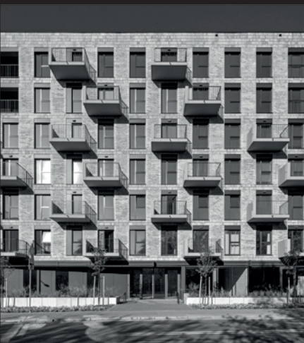
CEGLANE BUDYNKI PRZY GRODZIŃSKIEJ GRODZIŃSKA BRICK BUILDINGS
