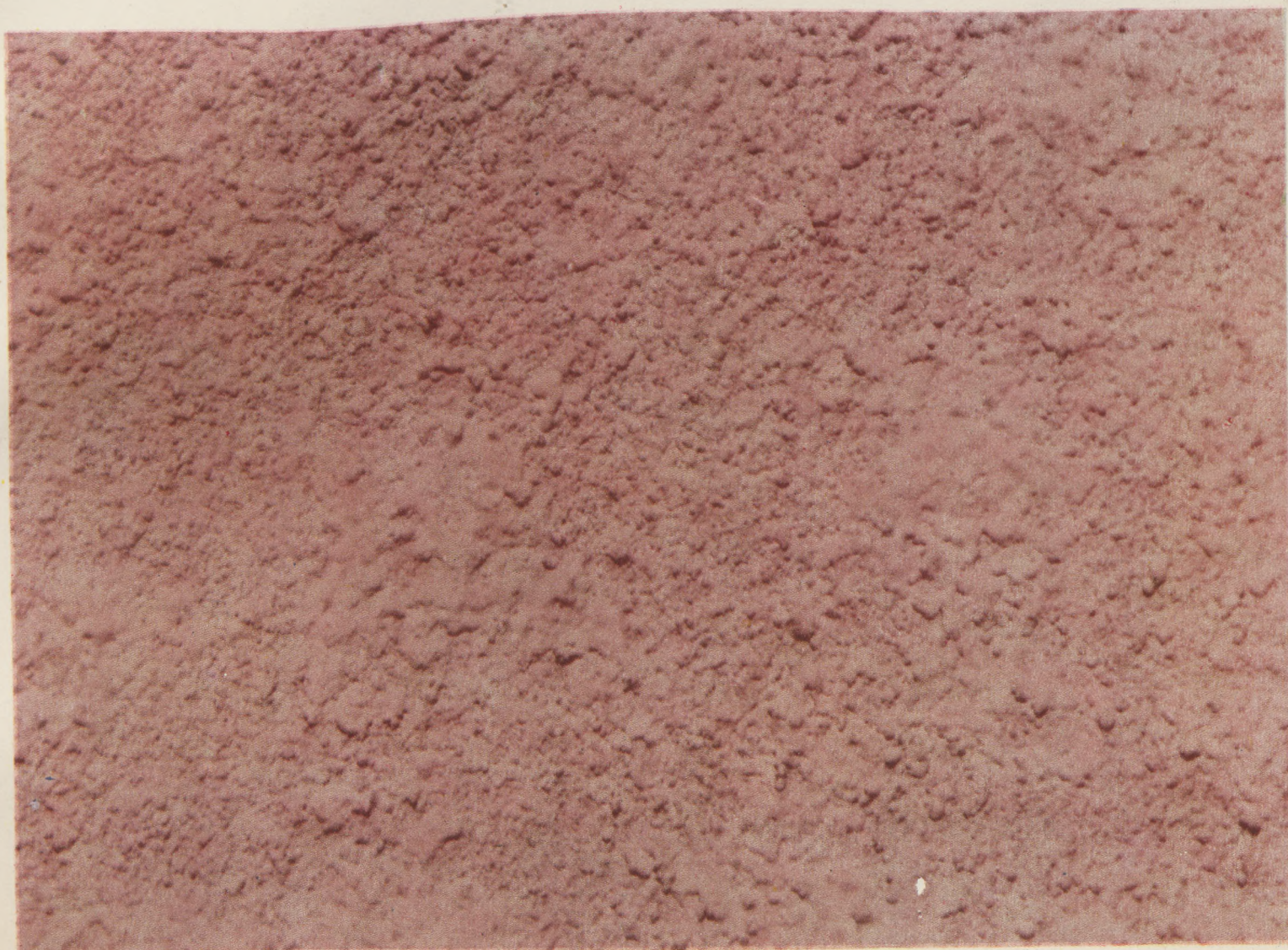
Tynk szlachetny lub półszlachetny), z bardzo rzadkiej zaprawy, nakrapiany miotelką, tzw. „baranek“ drobnoziarnisty
