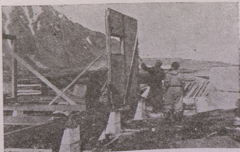
Ustawienie na podwalinie pierwszych płyt ściennych budynku. Od zewnątrz były następnie nabijane drewniane prefabrykalne szalunki.
