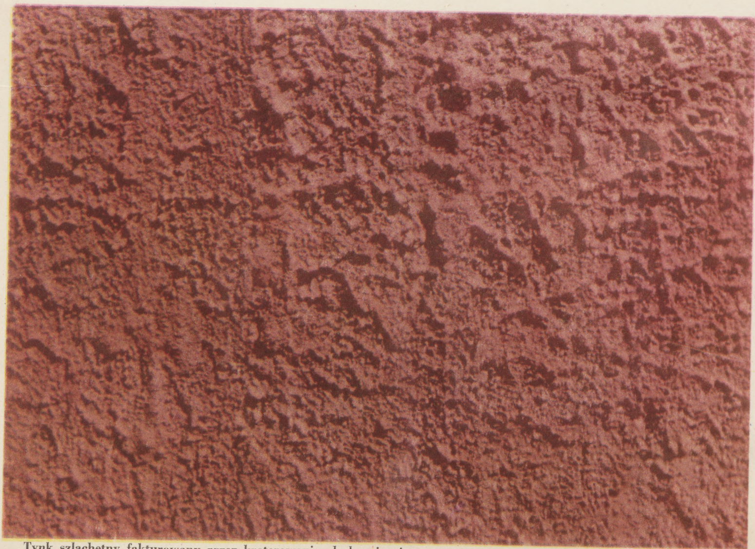
Tynk szlachetny fakturowany przez kraterowanie, drobnoziarnisty
