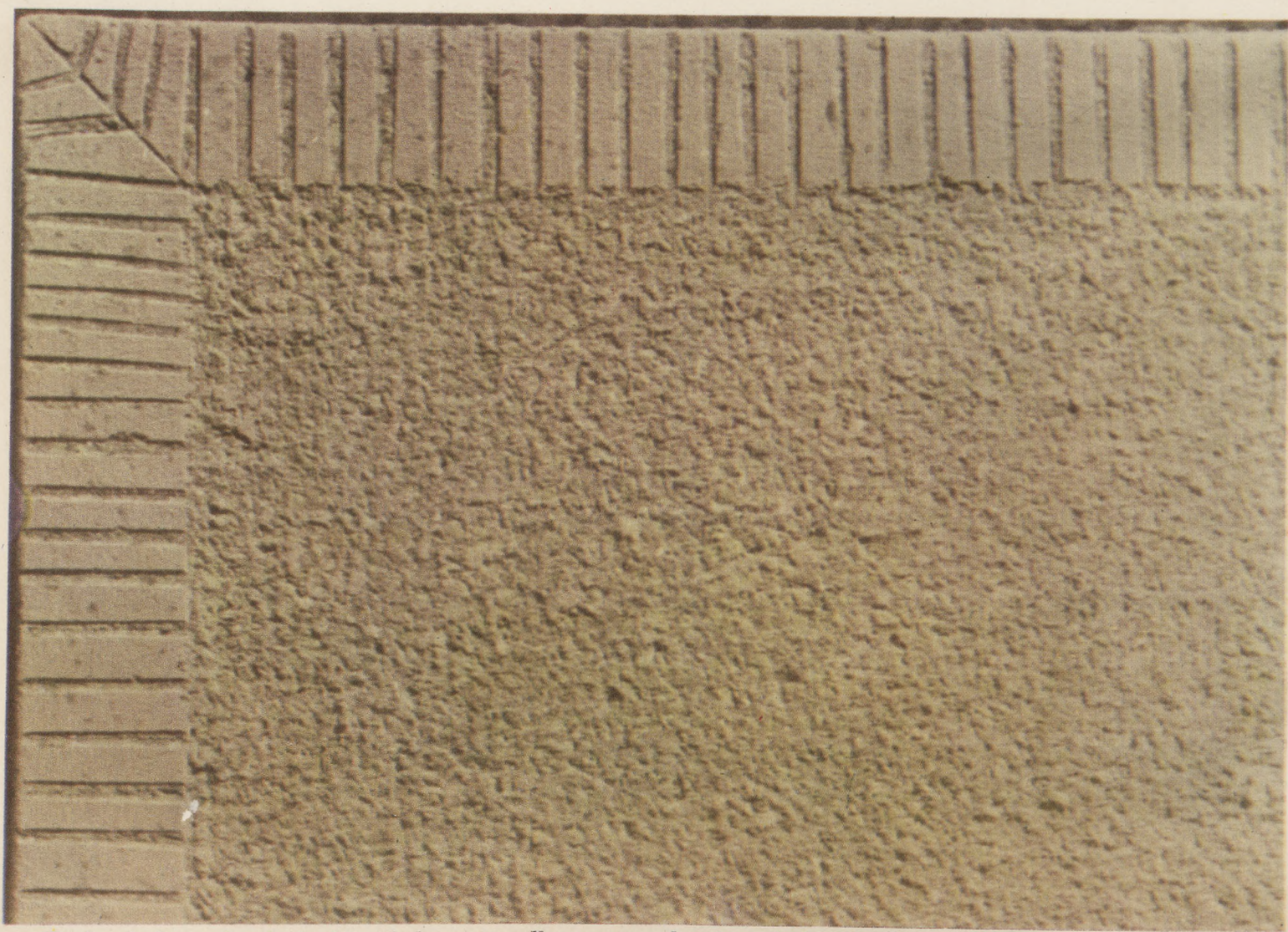
Tynk szlachetny kamieniarski, młotkowany z dłutowanym obrzeżem, drobnoziarnisty
