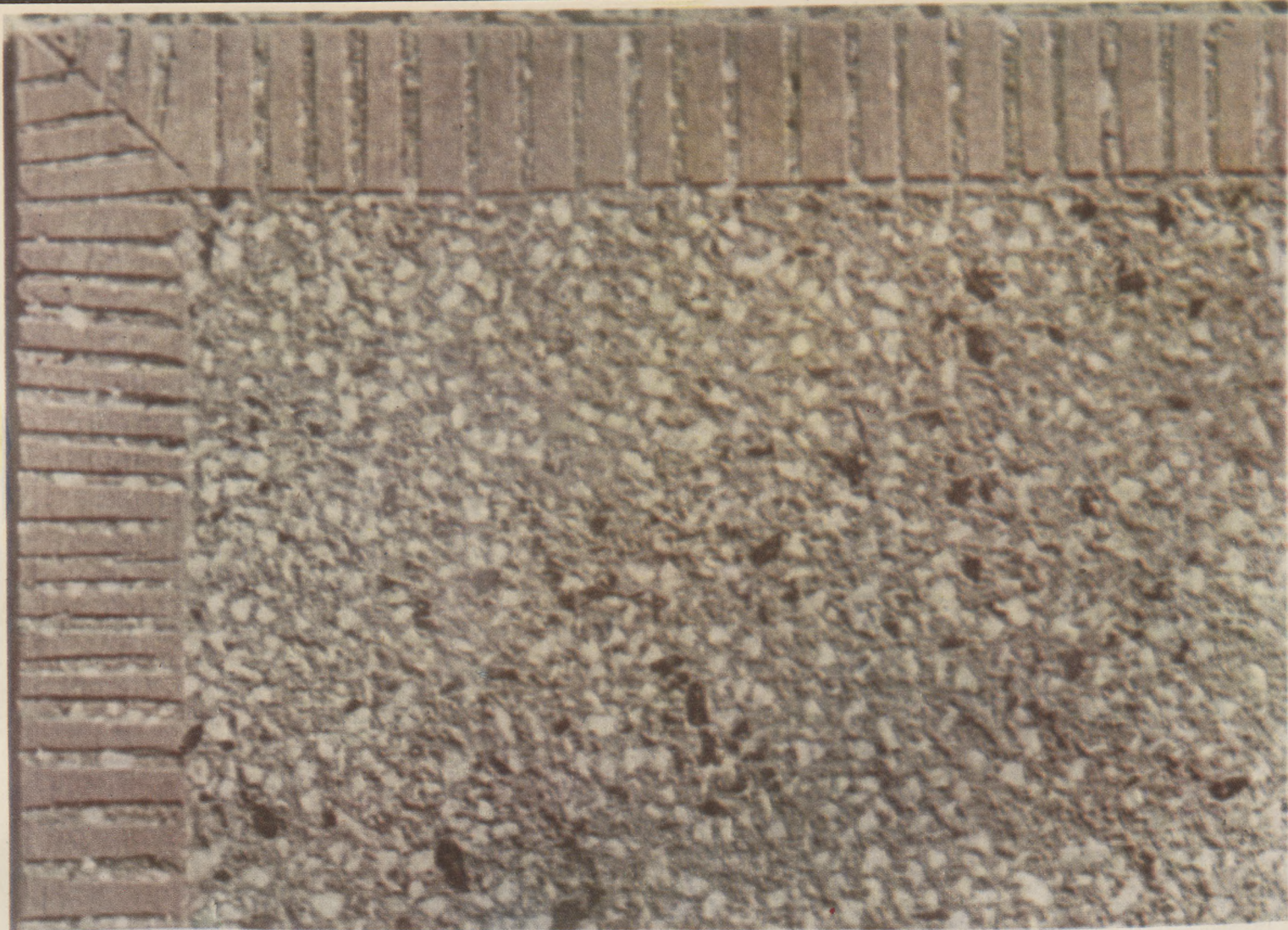
Tynk szlachetny kamieniarski, młotkowany z dłutowanym obrzeżem, średnioziarnisty
