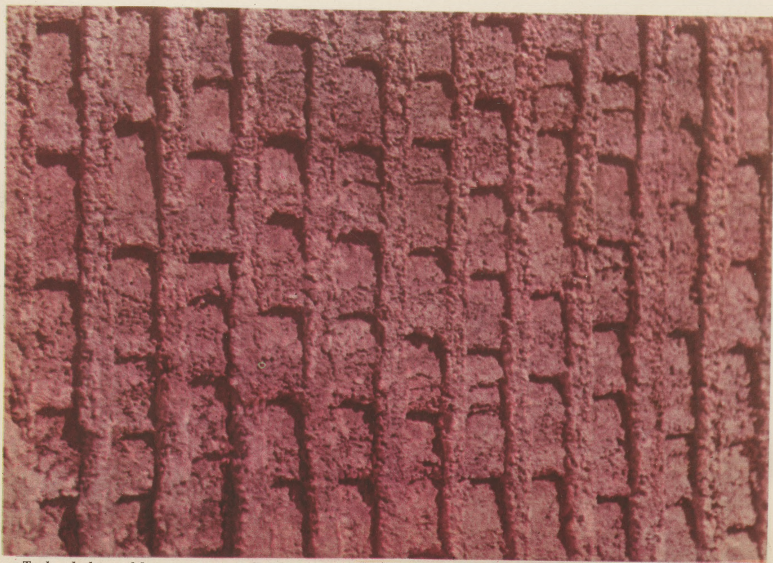
Tynk szlachetny fakturowany przez dociskanie lancetem (strzałką), drobnoziarnisty
