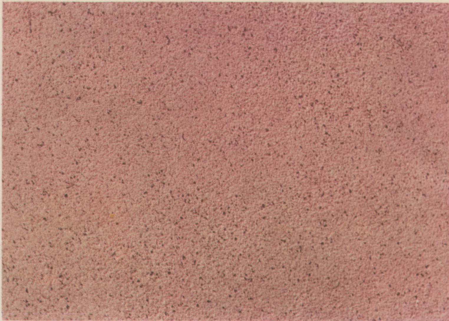
Tynk szlachetny na prefabrykatakach, zmywany, drobnoziarnisty
