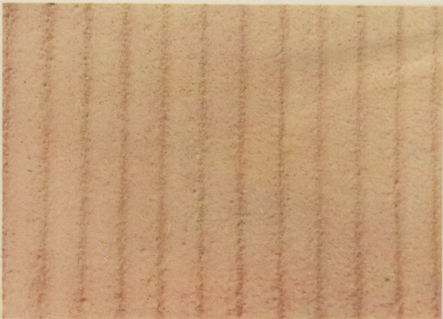
Tynk szlachetny na prefabrykatakach, rowkowany przez strychowanie i piaskowany piaskownicą, drobnoziarnisty
