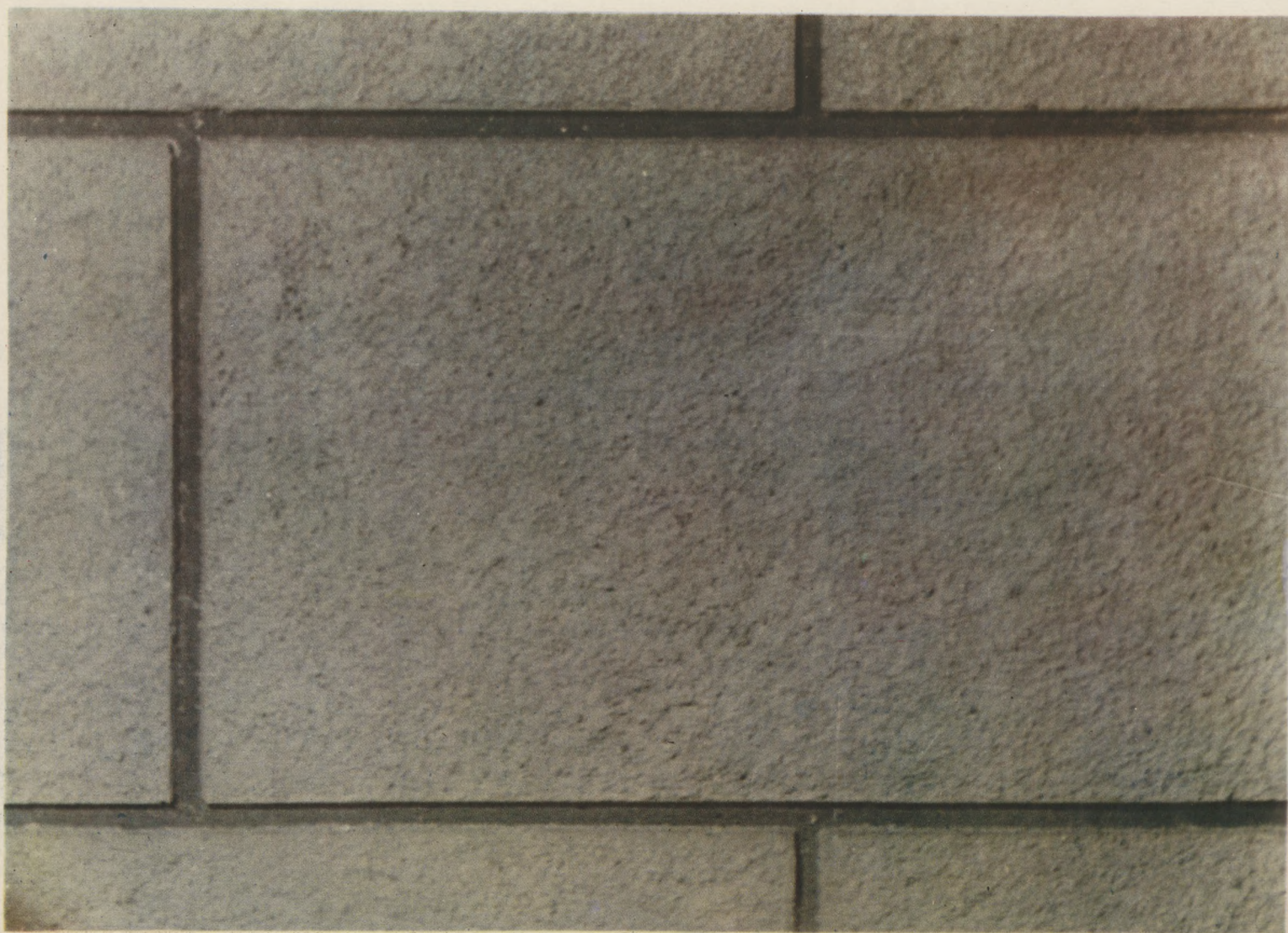
Tynk szlachetny nakrapiany aparatem pneumatycznym dwuwarstwowo (druga warstwa boniowana przez założenie listew) drobnoziarnisty (zwiększenie ok. 4-krotnie)
