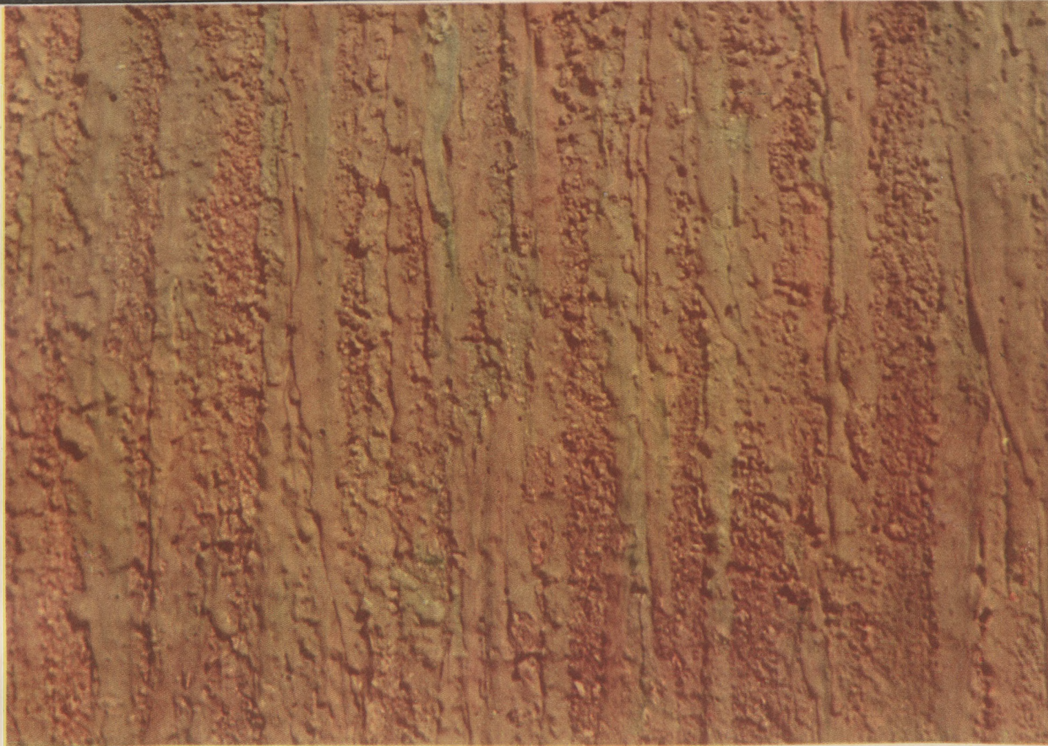
Tynk szlachetny fakturowany przez kropłowanie wielobarwne, dwuwarstwowy, bardzo drobnoziarnisty na średnioziarnistym
