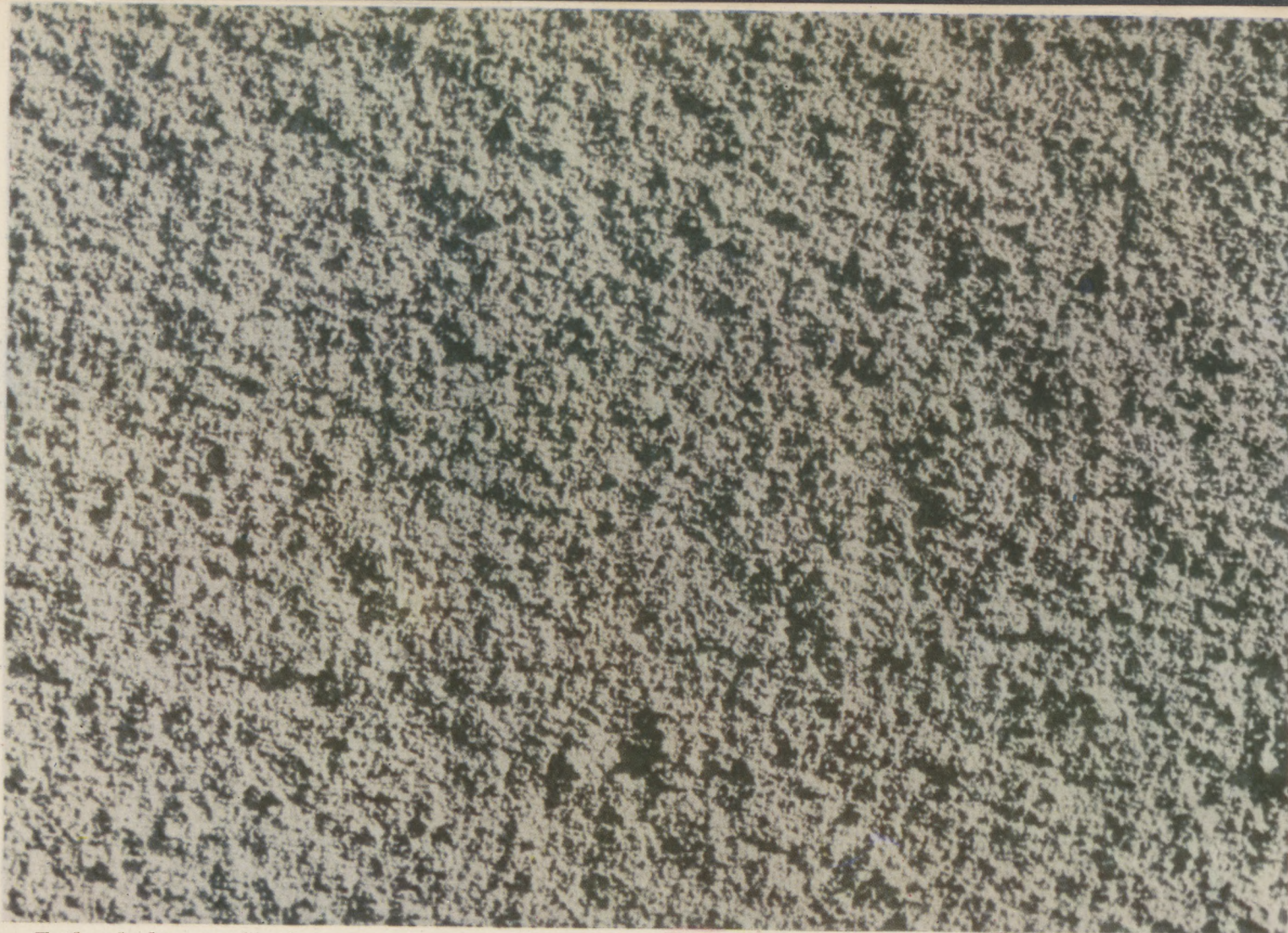
Tynk szlachetny nakrapiany aparatem pneumatycznym, drobnoziarnisty
